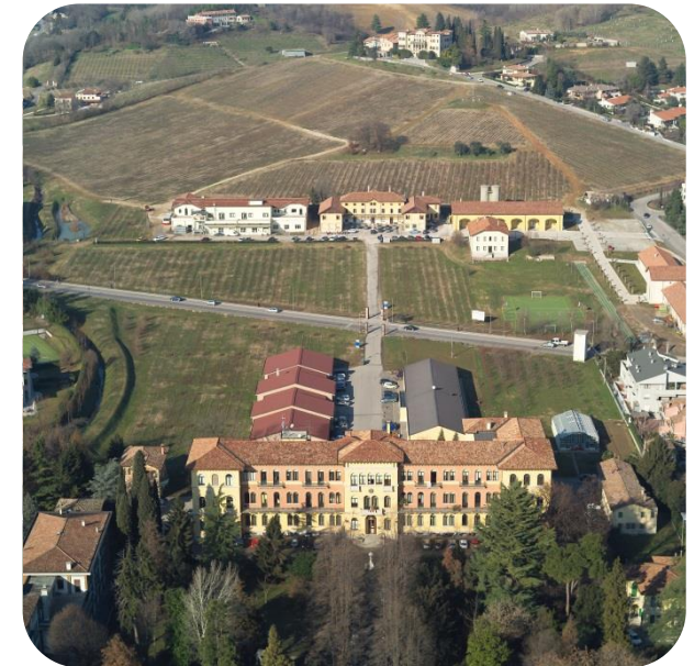
Campus di Conegliano
