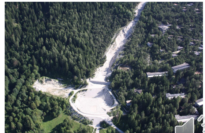
Bacini di contenimento di sedimenti
